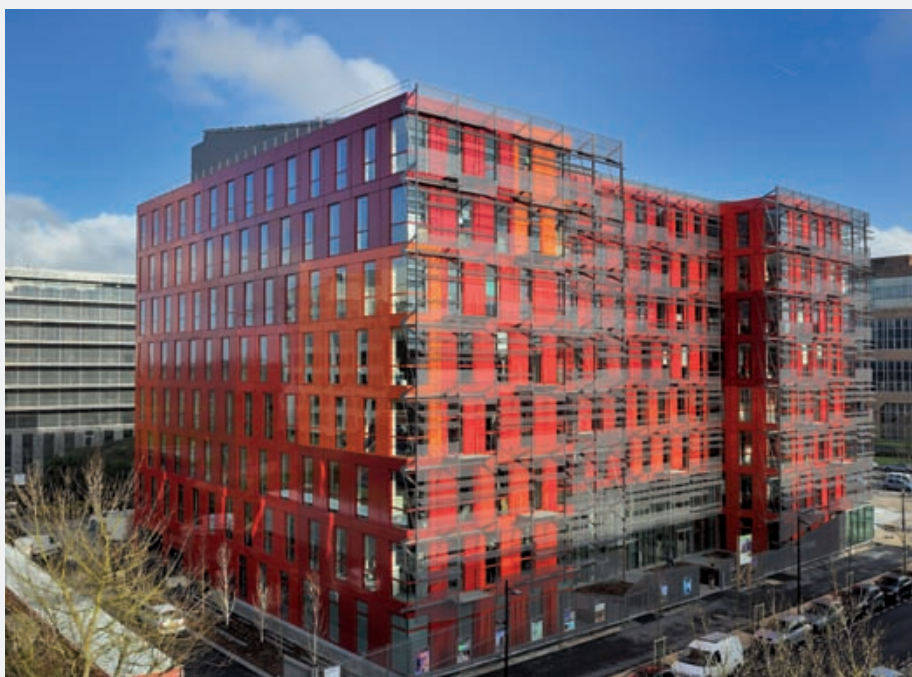
Bâtiment Australia, siège de Bouygues Energies & Services à Montigny-le-Bretonneux (78), équipé avec EcoFlex'IT™
